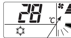
A velocidade do ventilador está ajustada para “High” no arrefecimento.
